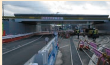
現在の国道294号白河バイパスの様子
