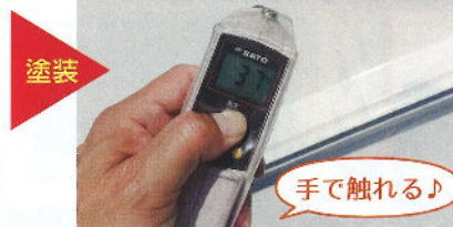
遮熱塗料を塗装面
